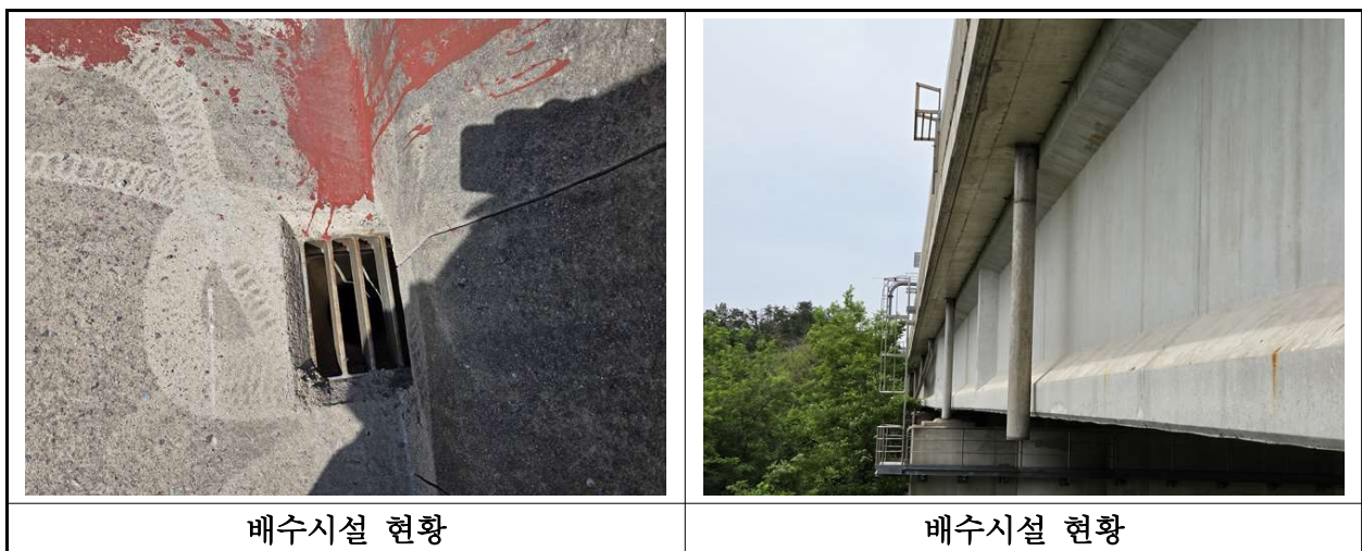
【사진 43.3.22】 배수시설 전경
