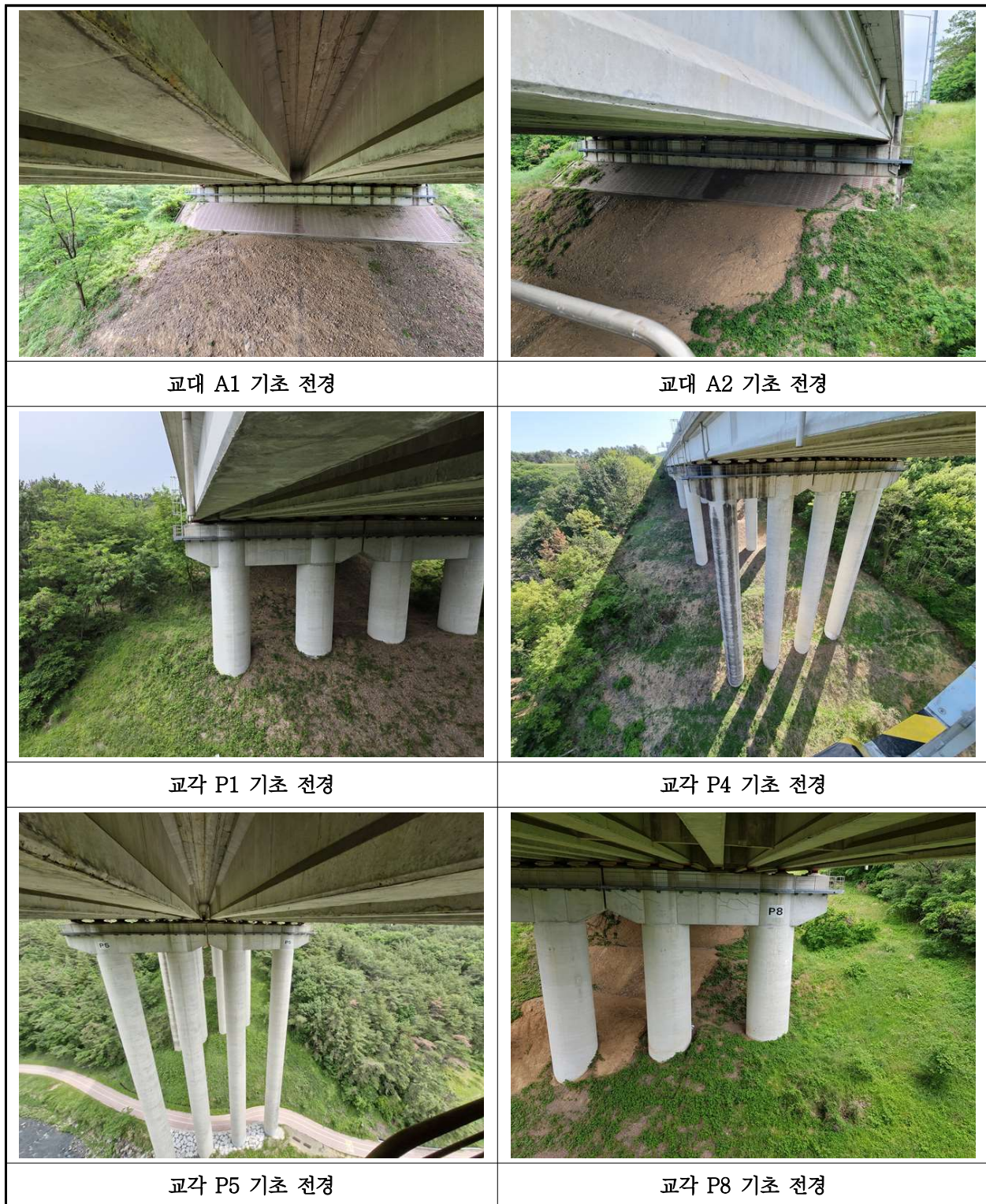
【사진 43.3.12】 기초 전경
