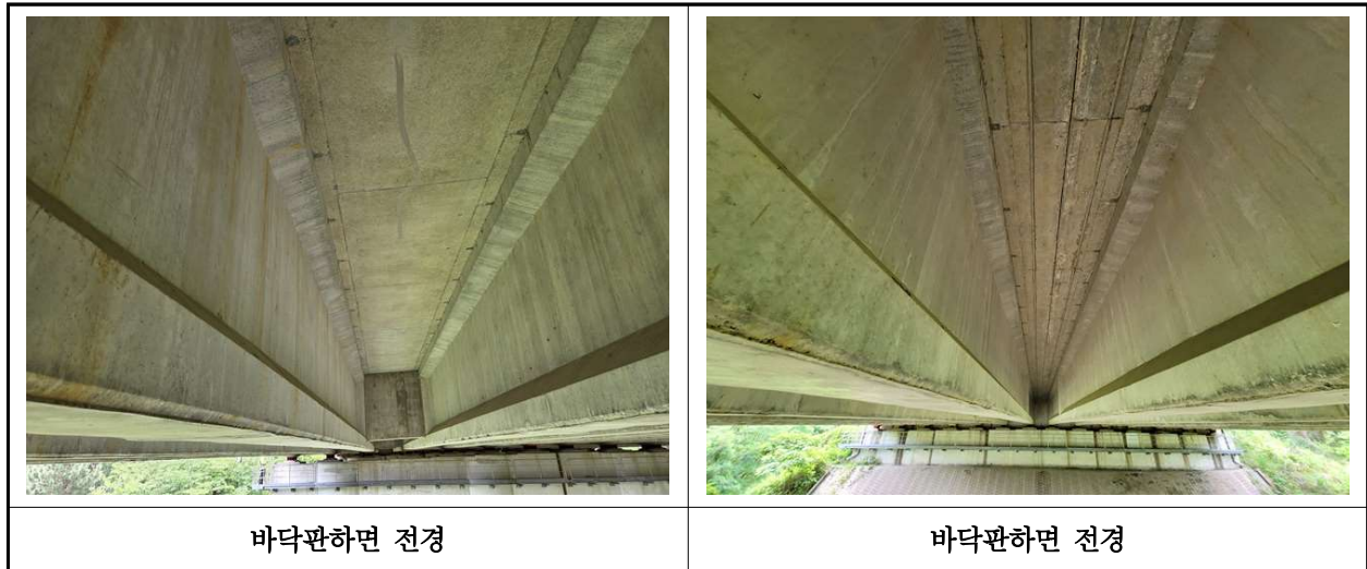
【사진 43.3.2】 바닥판하면 전경
