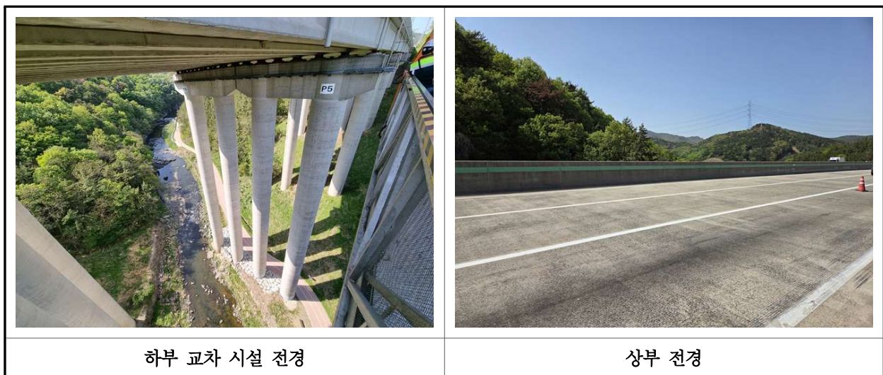
【사진 43.2.1】 주변환경 및 하중변화 전경
