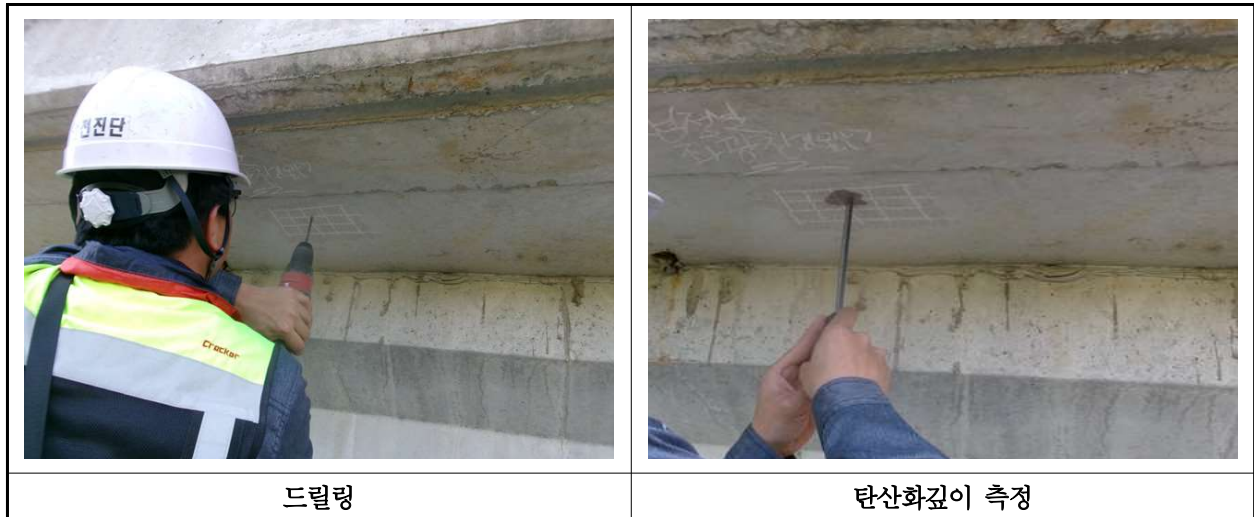
【사진 43.4.3】 탄산화 깊이 측정 현장사진
