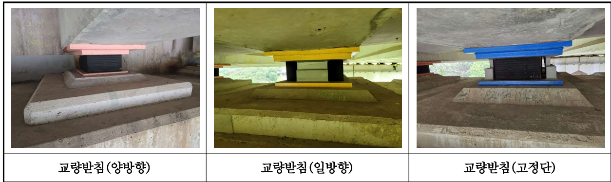
【사진 43.3.13】 교량받침 전경
