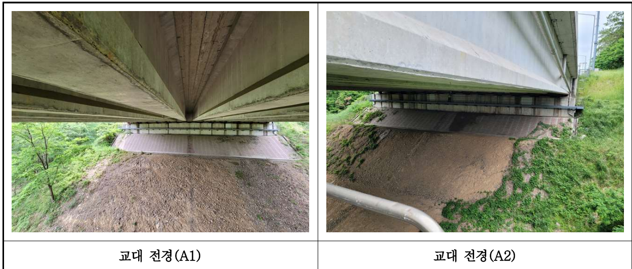
【사진 43.3.8】 교대 전경
