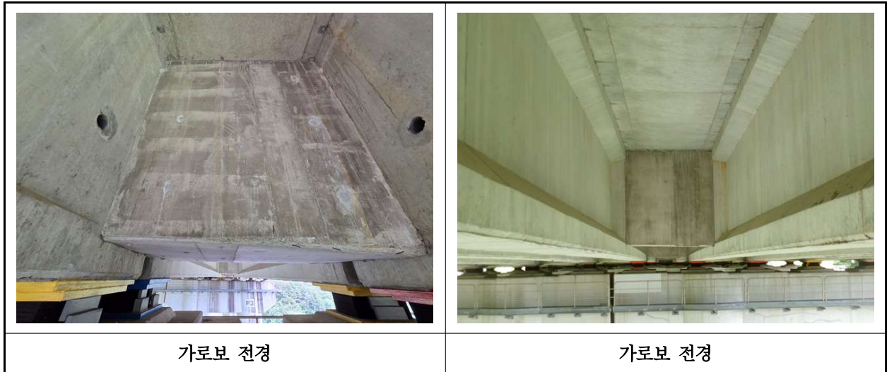
【사진 43.3.6】 가로보 전경
