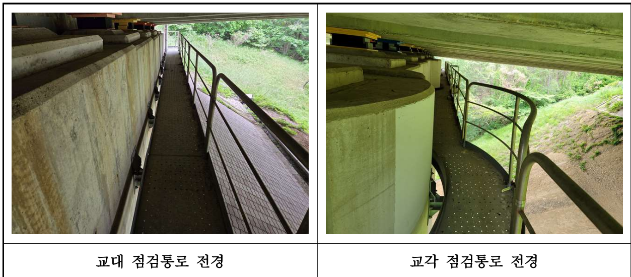
【사진 43.3.26】 교량 점검시설 전경
